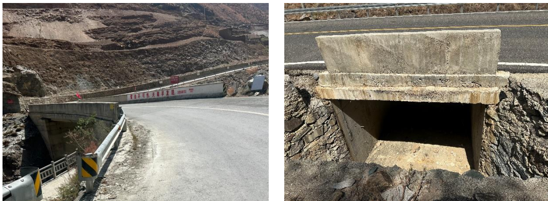
图 1.1-3 典型桥梁、涵洞现场照片
