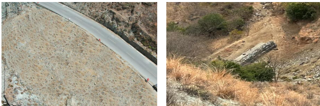
图 1.1-7 启用的 2 处弃渣场
