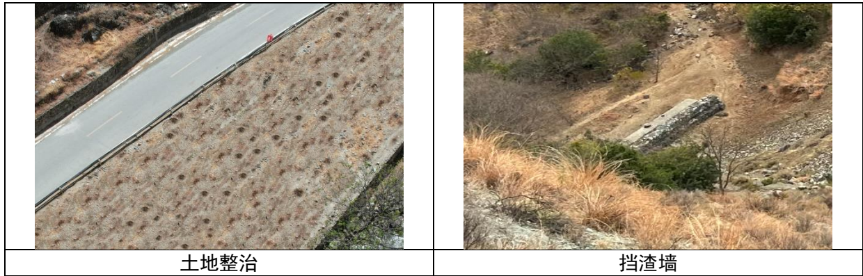
图 4.1-6 工程措施实施情况
