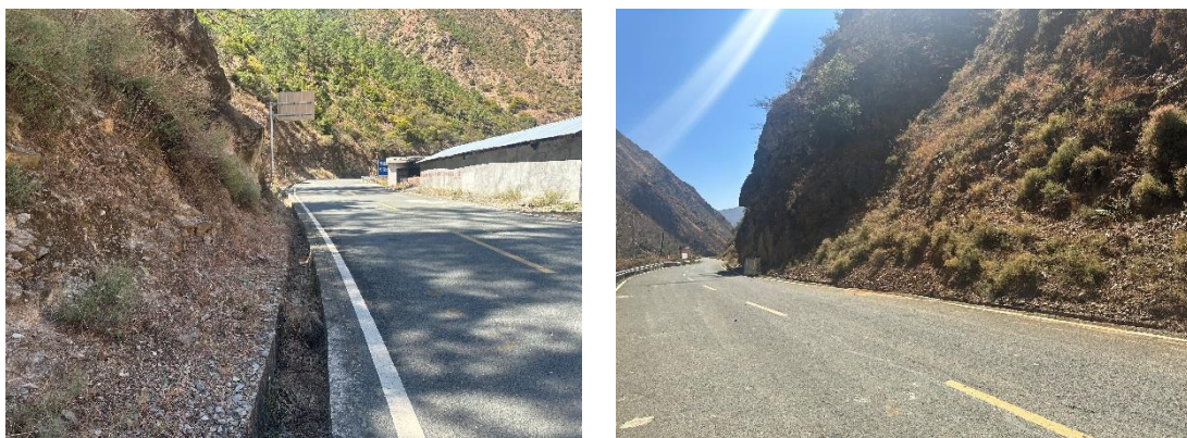
图 1.1-2 路基路面工程现场照片
